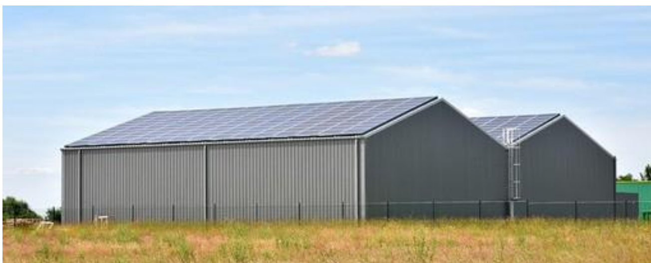
Le nouveau bâtiment de Valdem et ses 265 panneaux solaires, à Vendôme.
